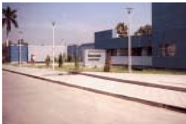
Edificación del Centro de Diagnóstico de Sanidad Animal
